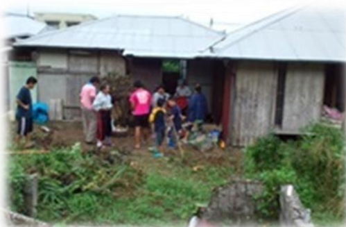
空き家の改修
