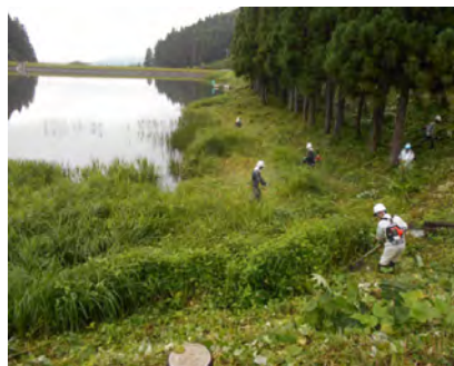
ため池堤体の草刈作業
