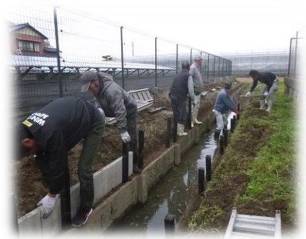
直営施工による 水路側壁の嵩上げ
