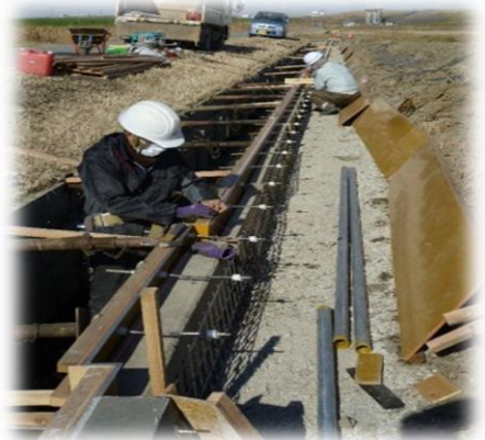
水路側壁の嵩上げ工事
