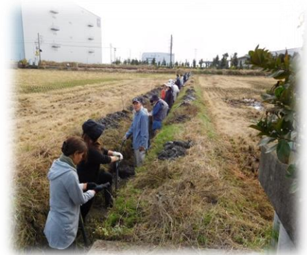
地域住民と協働で 水路の泥上げ
