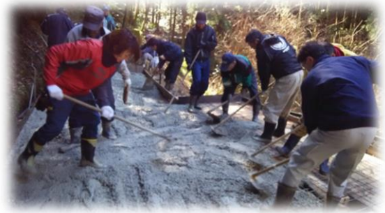
直営施工による農道の舗装
