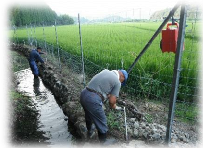
防護柵の補修・強化
