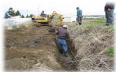
農道側溝の土砂上げ
