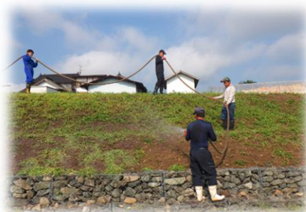
センチピードグラスの植栽作業
