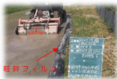
水田からの濁水の流出防止 (畦畔フィルムの布設)
