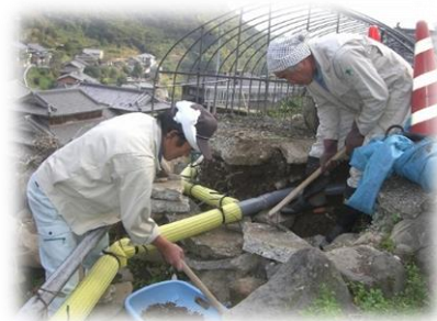
パイプラインの補修
