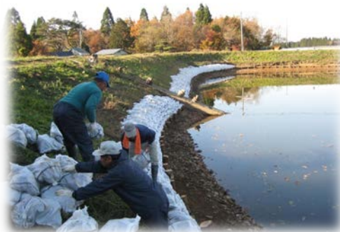
ため池堤体の補強
