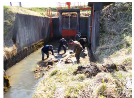
水路の泥上げ
