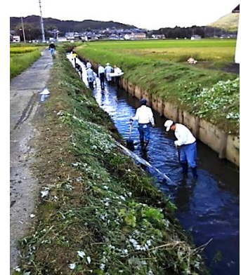
泥上げ作業の様子
