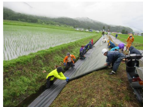
防草・抑草シートの敷設
