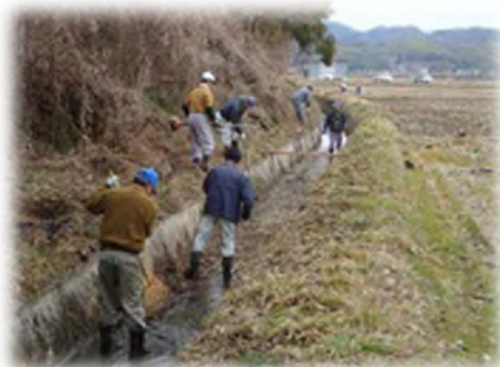
水路周辺の草刈りと泥上げ
