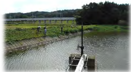
ため池の管理状況
