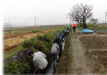
水路の泥上げ
