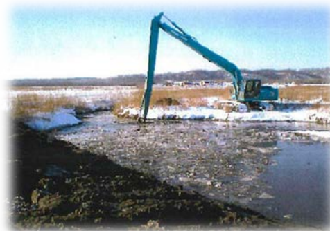
沈砂池の土砂上げ
