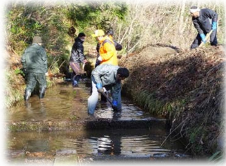
水路の清掃作業の様子
