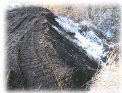
農用地法面の初期補修 (上：補修前、下：補修後)
