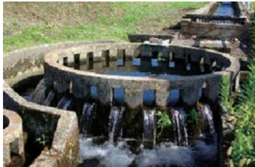
円筒分水による配水
