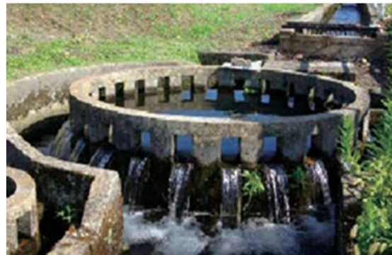
円筒分水による配水
