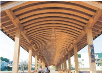
樹齢120年の飫肥杉と飫肥石を使い、くぎなどの金属を使わない伝統工法の「木組み」で造られている。天井は飫肥杉の特徴である弾力性を生かした「曲げ木」でできています。夢見橋周辺の広場には、赤レンガが敷き詰められています。また、堀川運河の護岸には飫肥杉で造られたウッドデッキが整備されており、新たな油津のシンボルとして、市民の憩いの場にもなっている。
