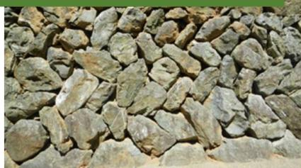
約400年前から傾斜地の崩落防止と耕地確保のため、垂直に近い石積みにより段々畑を構築してきました。
