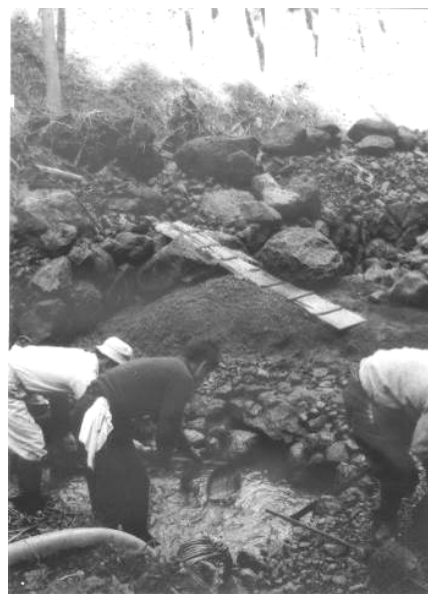
写真 41 狩野川台風襲来後の復旧工事の様子
