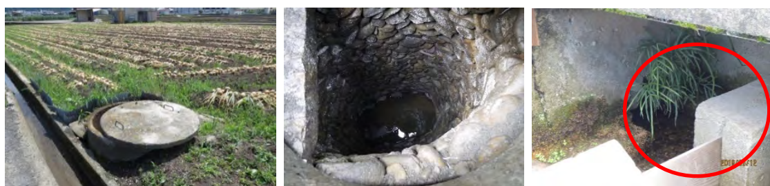
写真 34 暗溝の縦井戸(左)と内部(中)、水の出口(右)
