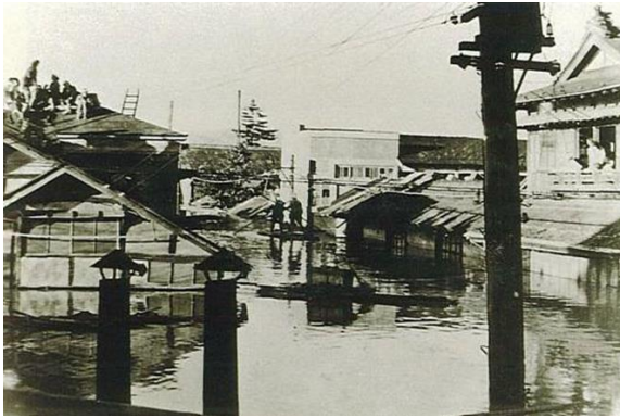
写真4 昭和22年カスリン台風時の一関中心部(1階部分が浸水)
