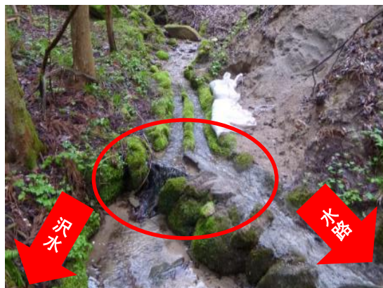
写真 35 石製水路による沢水の分岐 ○内：分岐点
