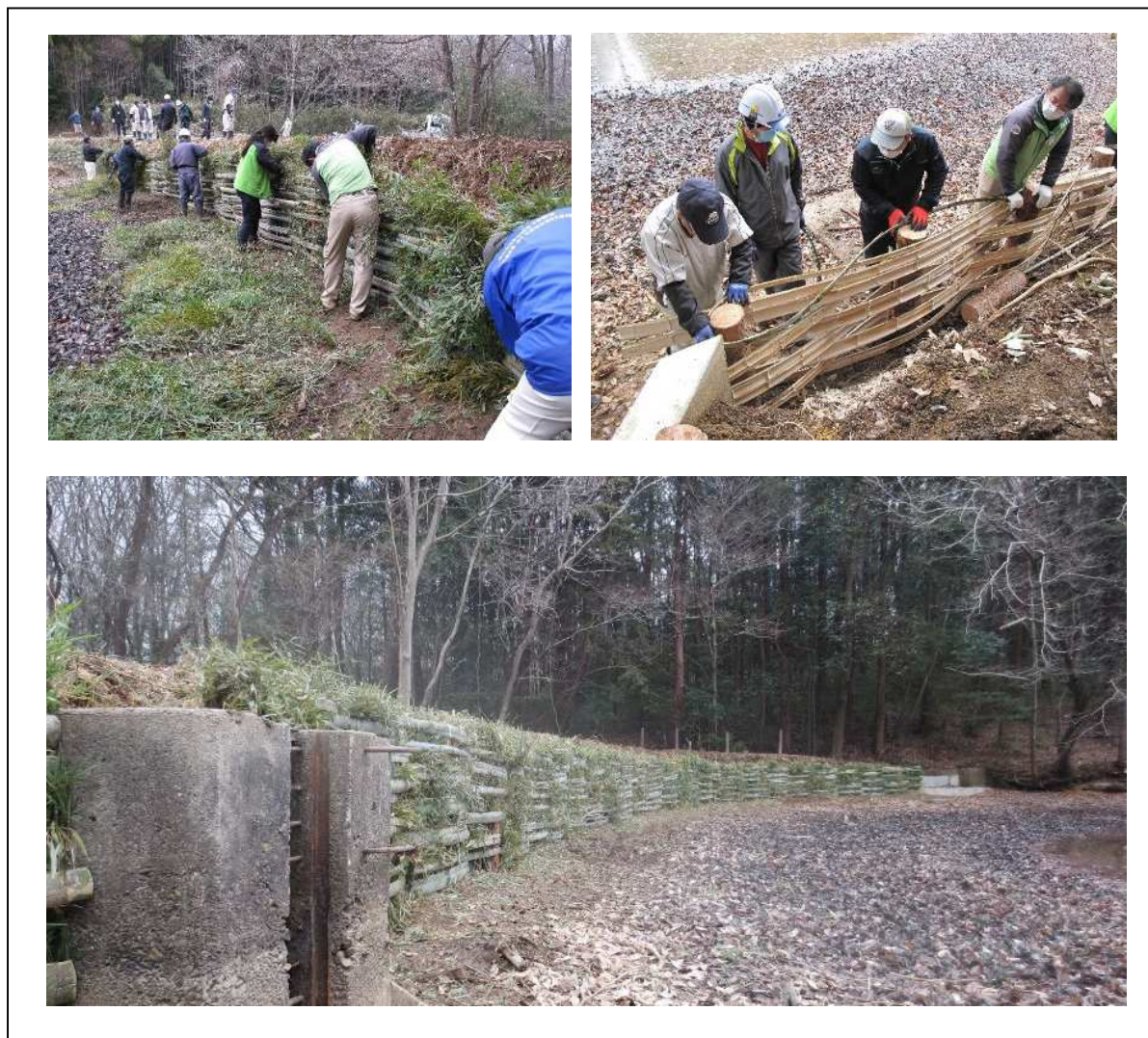
図34 昔ながらの沼堤復活作業の様子（滑川町）
