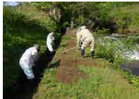
井堰・取水口清掃
