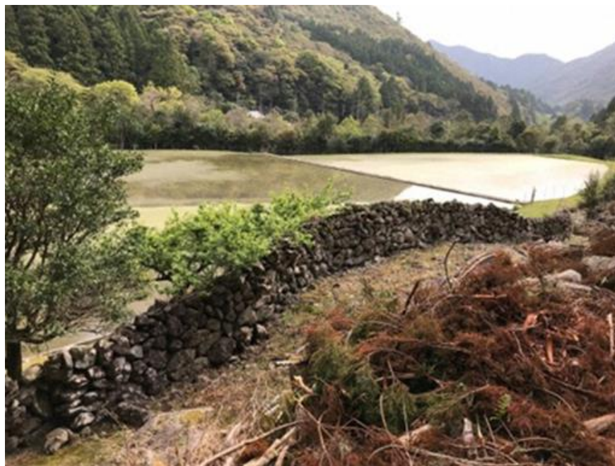
図 73 山から耕作地へのシカ、イノシシ等の侵入を防ぐシシ垣。 現在も機能している（美波町）
