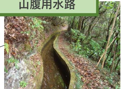
傾斜地にある棚田に水を確保するために、急峻な山腹に建設された山腹用水路。最古のものは、江戸時代中期頃に建設されました。総延長は約500kmになり、約1,800haの棚田に水を供給しています。
