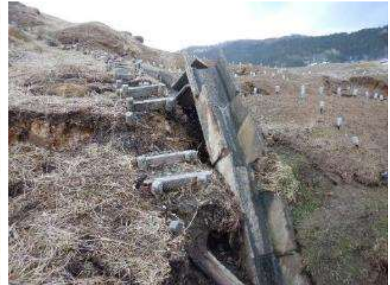
農地の亀裂・水路破損
