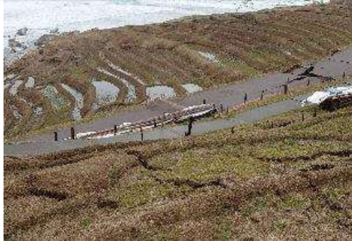
【地震】 白米千枚田の亀裂・法面崩壊（輪島市）
