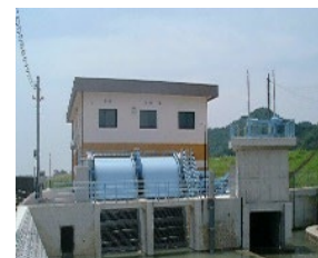
排水機場の整備
