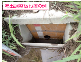
流出調整板設置の例
