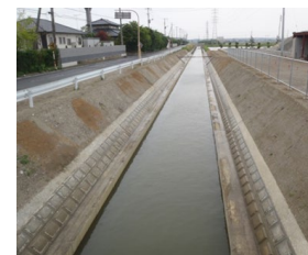
排水路の整備
