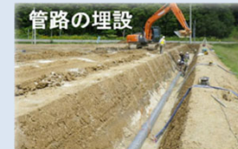
水路の管路化による 除草等作業労力の軽減
