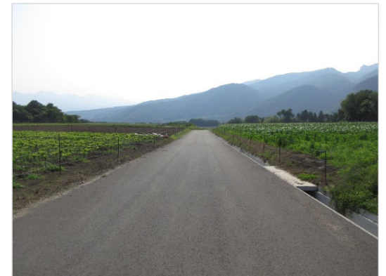
幅員が拡大された農道
