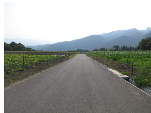
幅員が拡大された農道
