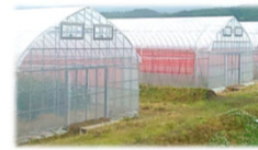
ビニルハウスの設置
