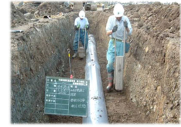
水路の管路化
