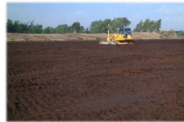
大規模な整地工
