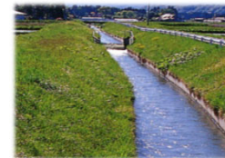
農業用排水施設の整備
