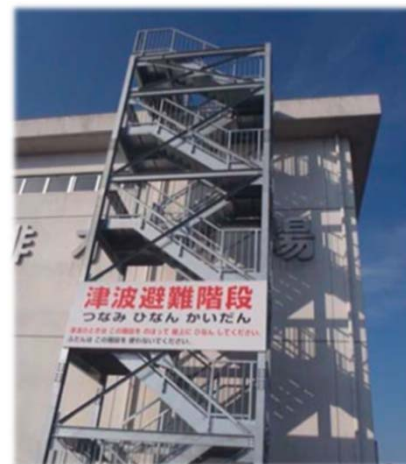
設置された避難階段 (出典：国土強靱化民間取組事例集)
