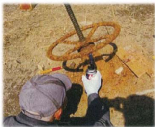
施設の保守管理
