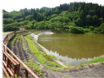
角間沢ため池
