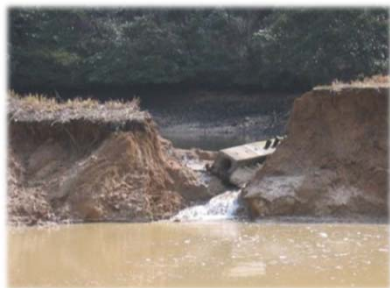
能登半島沖地震による平田池の決壊 (出典：志賀町農林水産課提供資料)
