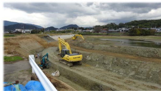
ため池の改修
