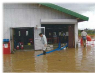
中山揚水機場被災状況 (H14) (出典：三郷堰土地改良区提供資料)
