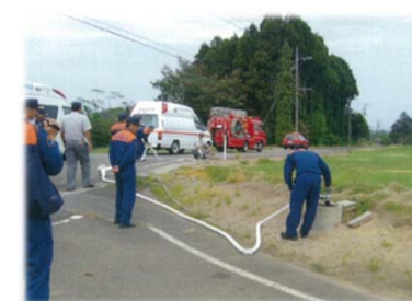
消防局との施設点検② (出典：大山山麓地区土地改良区連合提供資料)
