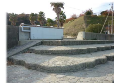
設置されたゲート（海側）
