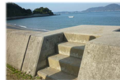
設置された階段工
