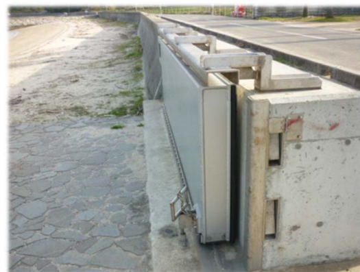
設置されたスライド式ゲート
