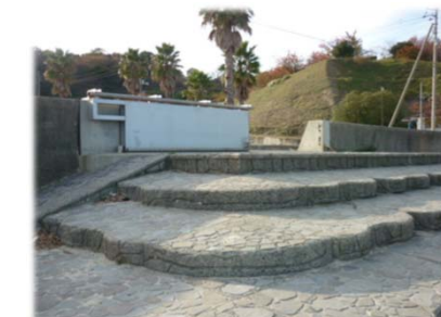
設置されたゲート（海側）
