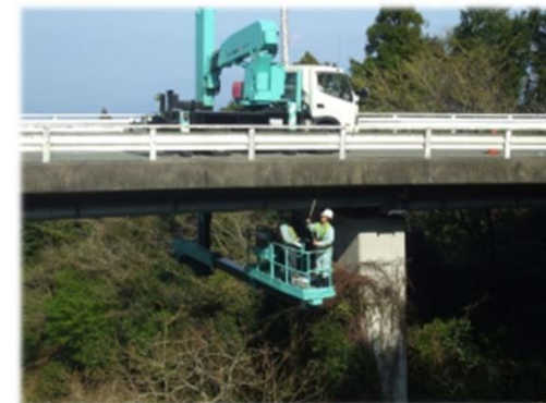
橋梁の点検状況 （出典：静岡県HP）
