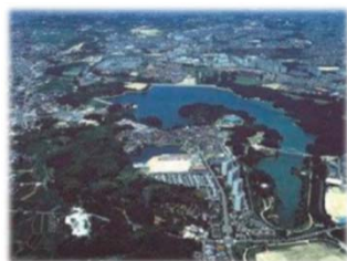
光明池全景 （出典：光明池土地改良区HPより）
