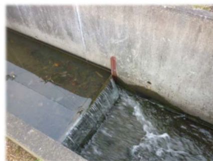
設置された堰上げ板
