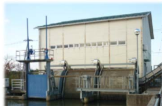
大場排水機場
