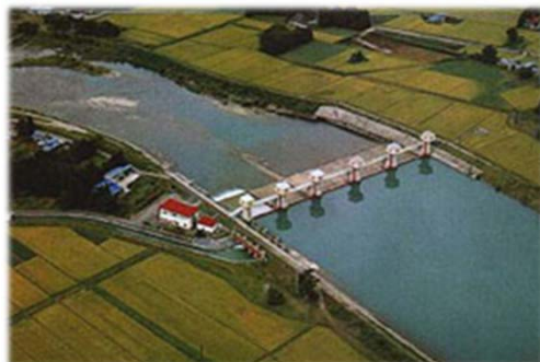
玉川頭首工全景 (出典：東北農政局HP)
