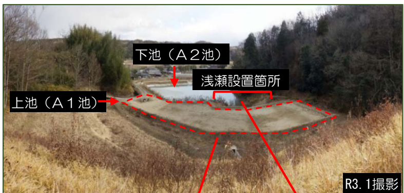
①ため池全景(手前がA1池廃止による埋立後、奥がA2池)
