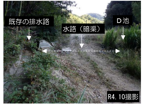
③排水路の状況
