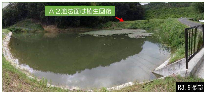
②ため池全景(A2池改修後)
