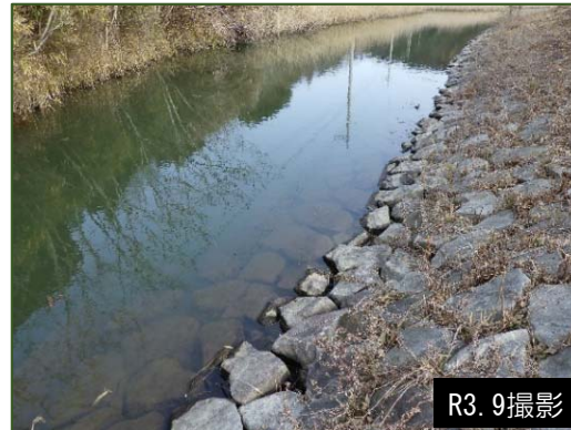
③遊水池の石張り護岸の様子
