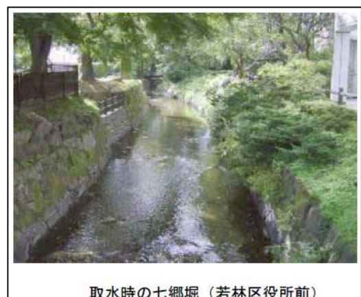
環境用水の通水状況
