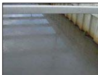
環境用水通水前（濁り）
