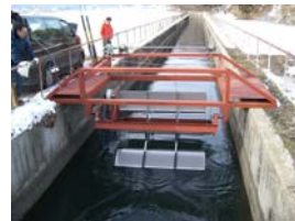
流水利用型発電機の設置状況
