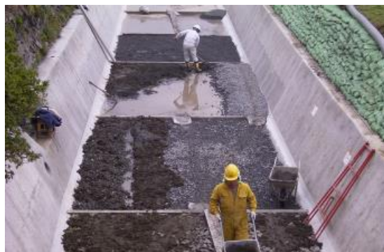
環境配慮対策施工状況
