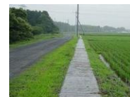
蓋が設置された水路
