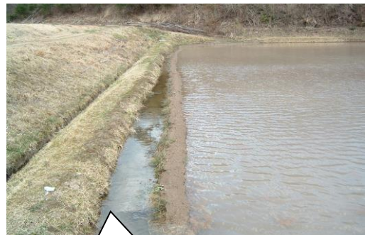
小水路の設置状況
