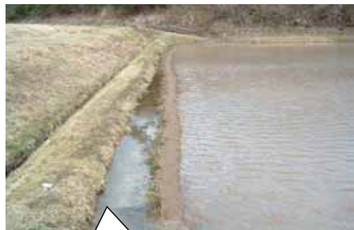
小水路の設置状況
