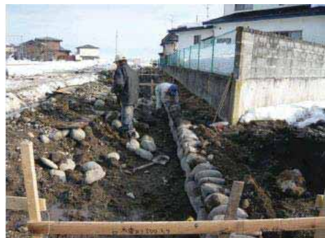
石積み水路の改修
