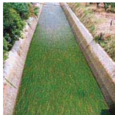
配慮対策施工後の水路
