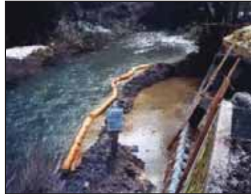
濁水防止フェンスによる抑制
