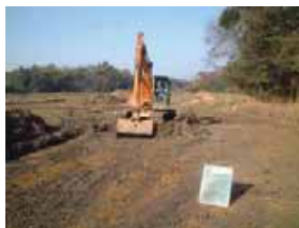
現況表土埋め戻しまでを実施
