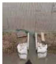
水路と水田との接続部
