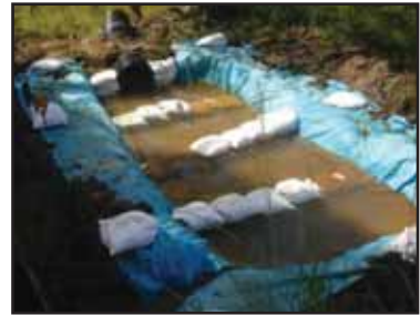
沈砂池に粗朶を入れ、土粒子の付着を促進
