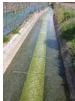
環境配慮対策改善後の水路
