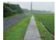
蓋が設置された水路
