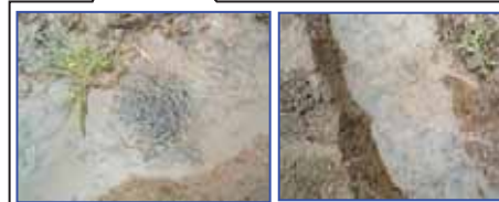
小水路の拡大写真
