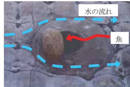
窪みによる水の流れと魚の移動の考え方
