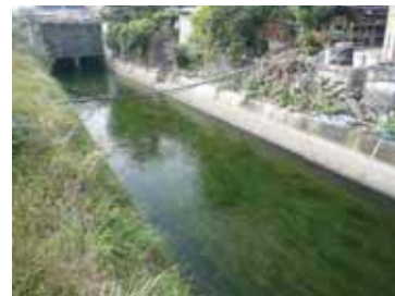
環境配慮対策実施後の水路
