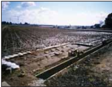
水田を借り入れ沈砂池として利用
