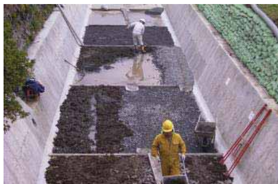
環境配慮対策施工状況
