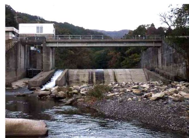
頭首工(改修前)
