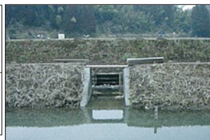
幹線排水路との連続性を確保
