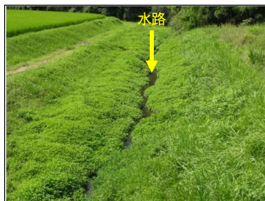
現況水路保全区間
