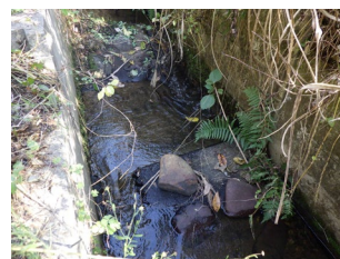
現場打ち魚道
