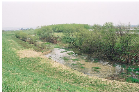
施工後における回避区間の状況
