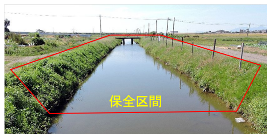
回避された土水路
