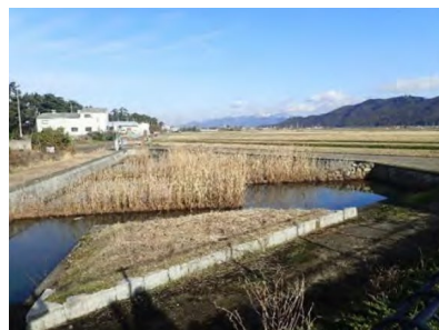
ナガエツルノゲイトウが侵入した循環かんがい施設の浄化池で、水田内に入 入するおそれがあることから、送水が 止められた事例
