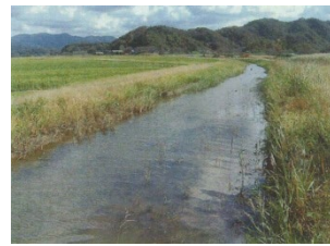
地区を流れる幹線排水路〔現況〕
