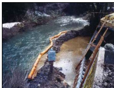
濁水防止フェンスによる抑制
