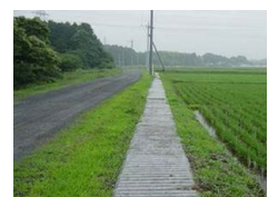
蓋が設置された水路
