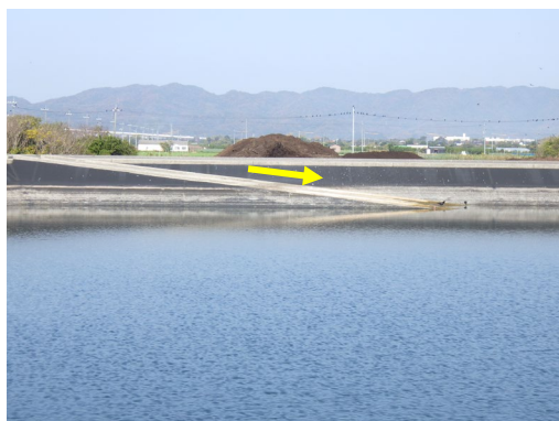
施設内へ下りるスロープの設置例
