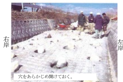
高強度マットにより形成された斜面に 粗石を設置した状況
