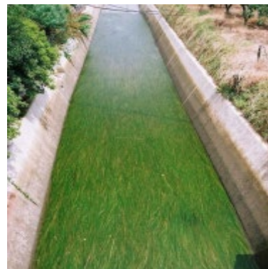
環境配慮対策施工後の水路
