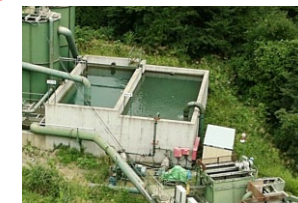
③濁水処理とポンプによる通水
