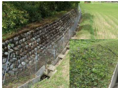
蓋版工の状況
