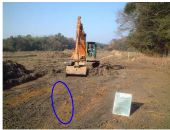
現況表土埋め戻しまでを実施
