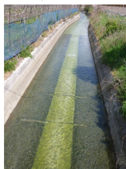
環境配慮対策改善後の水路
